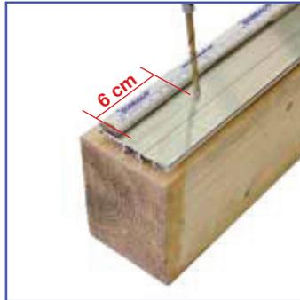
Profiliberteile im Abstand von 40 cm mittig vorbohren ( $\varnothing$  7 mm). Der Abstand der ersten Bohrung zur vorderen Kante beträgt 6 cm.
