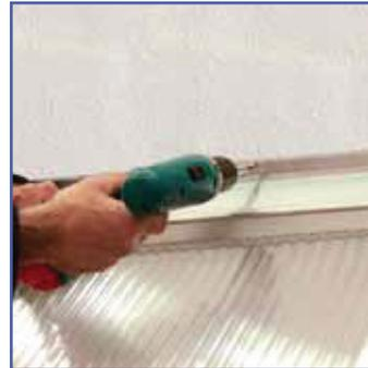
Verschrauben Sie das Profil mit geeigneten Schrauben.
