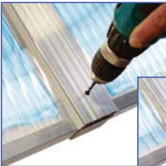
Nacheinander immer zwei Platten auflegen, ausrichten und fixieren. Kunststoffsteg durch die Bohrungen im Oberprofil vorbohren ( $\varnothing$  5 mm). Dann Profil und Steg mit Scobalit Edelstahlschrauben (Metall) 6,3 x 38 mm verschrauben.
