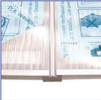
Legen Sie die Platte auf und richten Sie diese winkeltreu aus. Platteabstand 28 mm. Die gekennzeichnete Schutzfolie nach oben - UV-Schutz!
