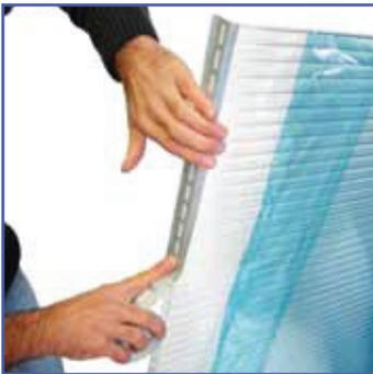
Bringen Sie das Kantenverschlussband am oberen Ende (Firstseite) der Platte an. Das Band verhindert das Eindringen von Staub, Schmutz und Insekten, lässt aber gleichzeitig die Durchlüftung der Hohlkammern zu.
