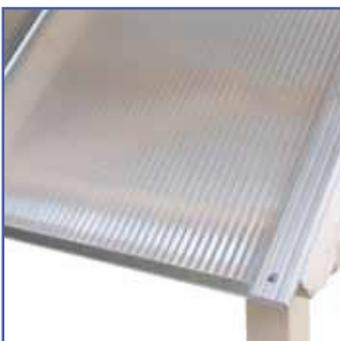
Entfernen Sie erst jetzt die Schutzfolien von der fertigen Dachfläche.
