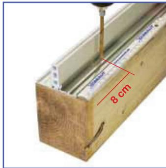
Profilunterteile im Abstand von 35 cm links und rechts vom Mittelsteg im Wechsel vorbohren ( $\varnothing$  5 mm). Der Abstand der ersten Bohrung zur vorderen Kante beträgt 8 cm.
