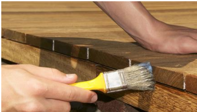
Auftragen von Hirnholzschutz auf Harthölzer
