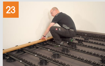
Erste und zweite Diele montieren
