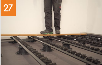
Erste und zweite Diele montieren
