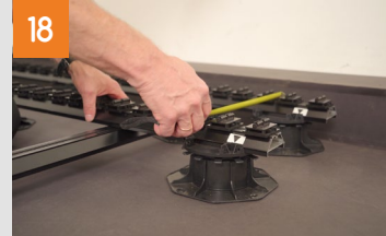
Systemschienen verlegen
