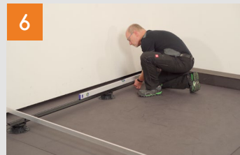
Konterlattung ausrichten
