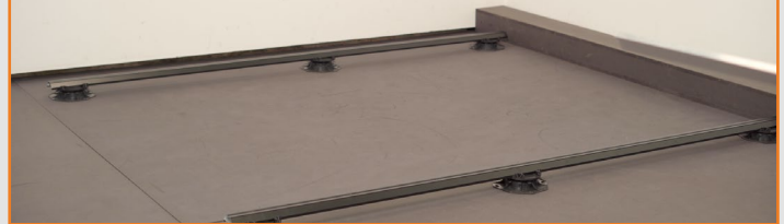
Konterlattung positionieren
