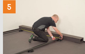
Konterlattung positionieren
