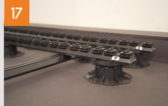
Systemschienen verlegen
