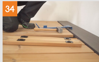
Diele herausnehmen und wieder einsetzen
