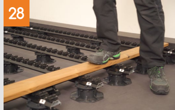
Erste und zweite Diele montieren
