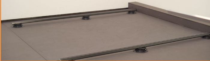
Konterlattung positionieren
