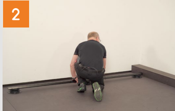
Konterlattung positionieren
